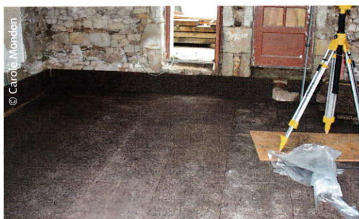
L'isolation des sols sur terre-plein se fera avec un matériau incompressible, non capillaire et non vulnérable à l'eau. Un seul est biosourcé : le liège expansé.
