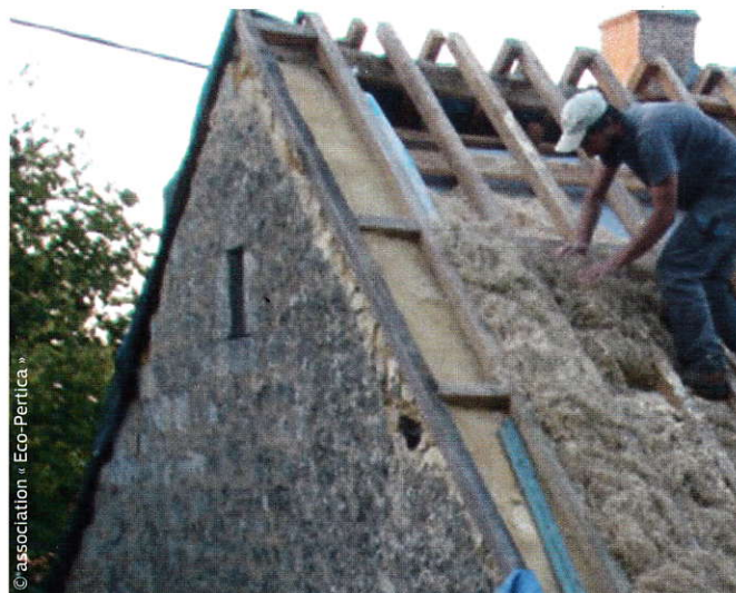
Mise en œuvre de laine de chanvre vrac en isolation toiture.
