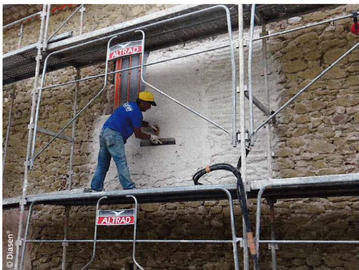
Réalisation d'un enduit isolant qui, dès 3 à 7 cm d'épaisseur (selon les produits), permet de faire la moitié du chemin pour atteindre le niveau BBC.
