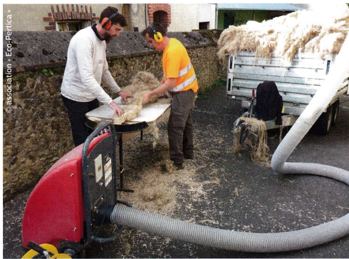
Cardage de la laine de chanvre pour mise en œuvre machine. Matériau local, la laine de chanvre vrac a un bien meilleur bilan environnemental que son homologue en rouleau ou en panneau.
