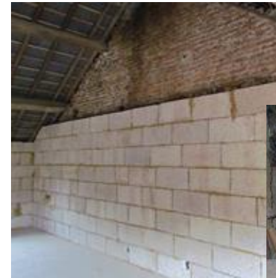
Cloison de doublage (photo ISOHEMP)
