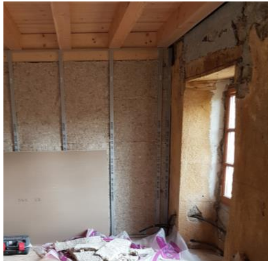
Isolation intérieure (photo Biofib)
