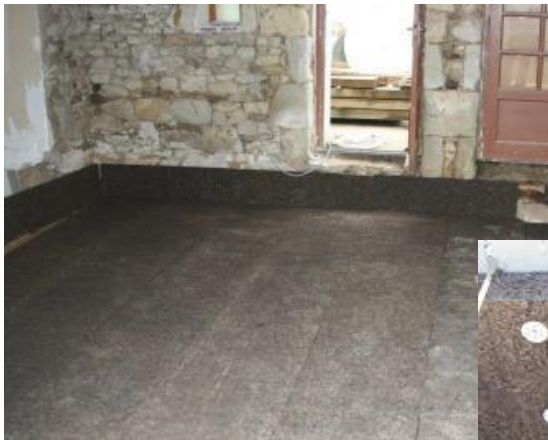
Panneaux de liège expansé en sol
