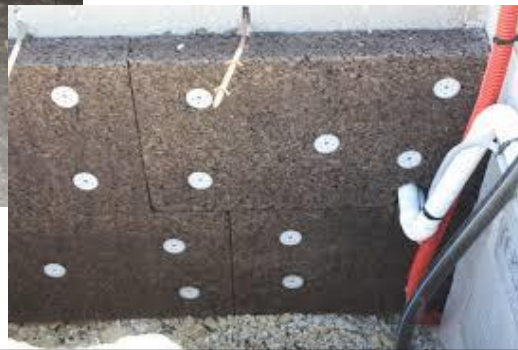
Panneaux de liège expansé en sol
