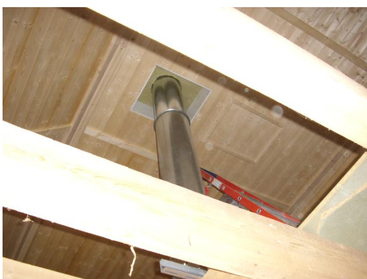
Un coffre rempli de laine de roche permet de réaliser la traversée toiture du conduit de cheminée.
