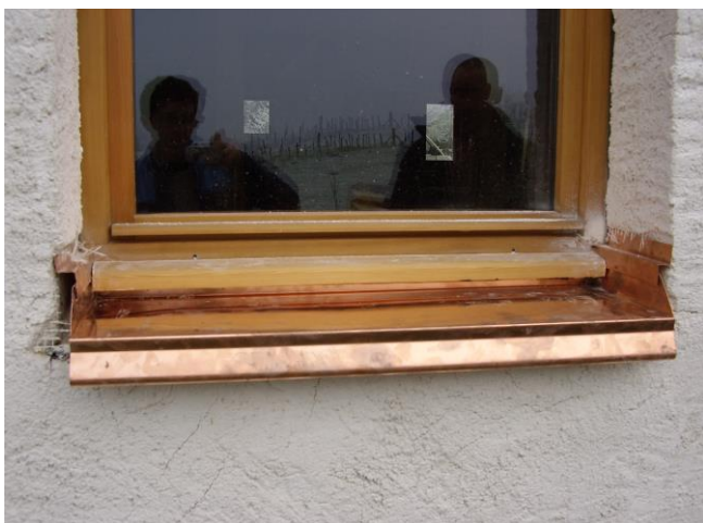
Le complexe d'étanchéité, en cuivre, est posé
