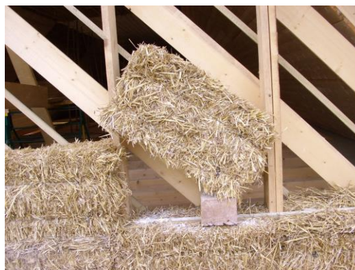
Pose de ballots avec fibre verticale
