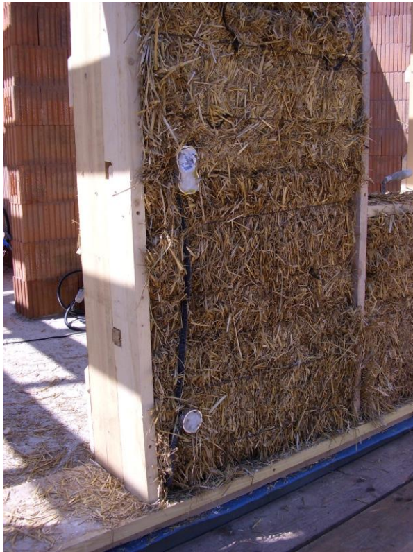
Insertion des boîtiers et gaines électriques
