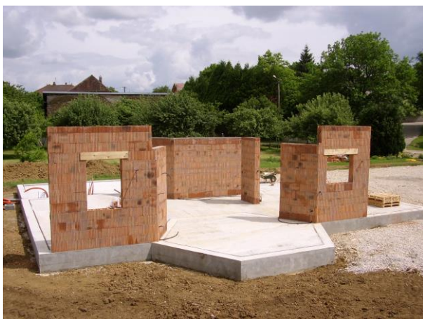
Réalisation des murs capteurs (1 er plan) et des refends qui auront entre autre pour objectif de stoker les calories
