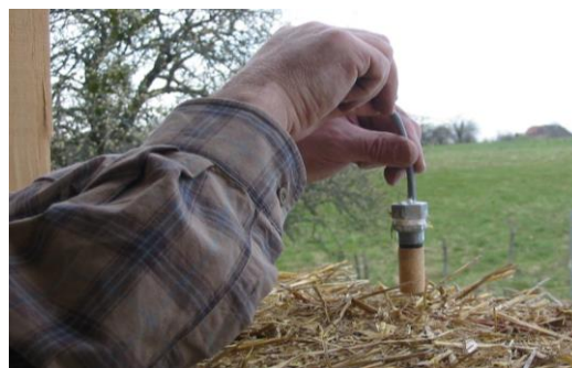
Pose d’une sonde pour le suivi hygrothermique du remplissage ‘paille’
