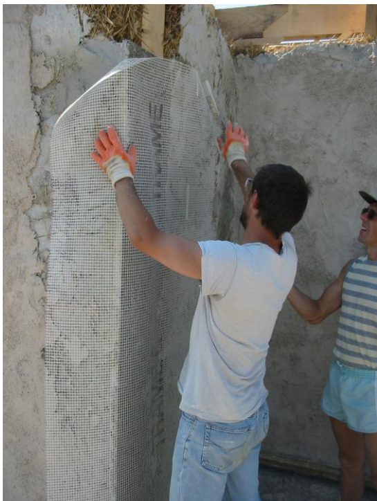
Pose de la trame en fibre de verre
