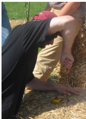
Utilisation d'une aiguille et coupe d'une botte
