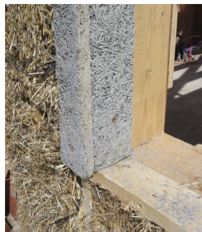
Pose de plaques Fibragglo en interface bois / enduits
