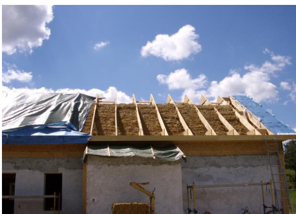
Vue de l'isolation toiture avant fermeture
