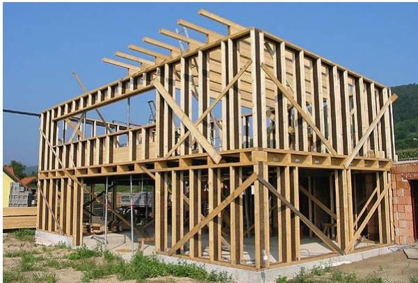
Ossature d'une maison à Rohrau, Autriche
