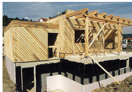
Pose des murs sur chantier...
