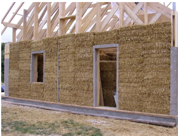
Base de Façade prête à enduire (mur égalisé, fibragglo posé)
