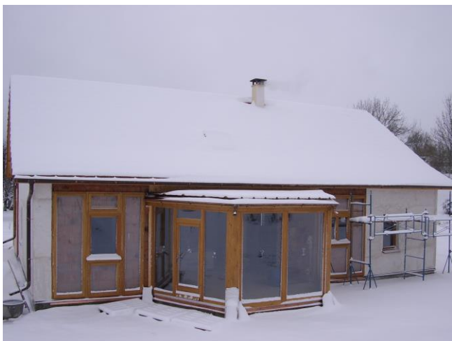
Hiver 2005/2006 : les finitions intérieures sont en cours.
