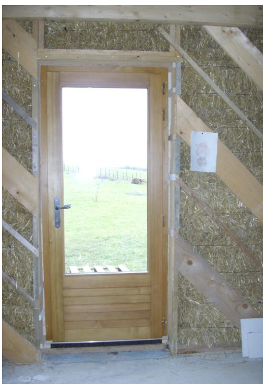
Vue intérieure d'une porte fenêtre posée
