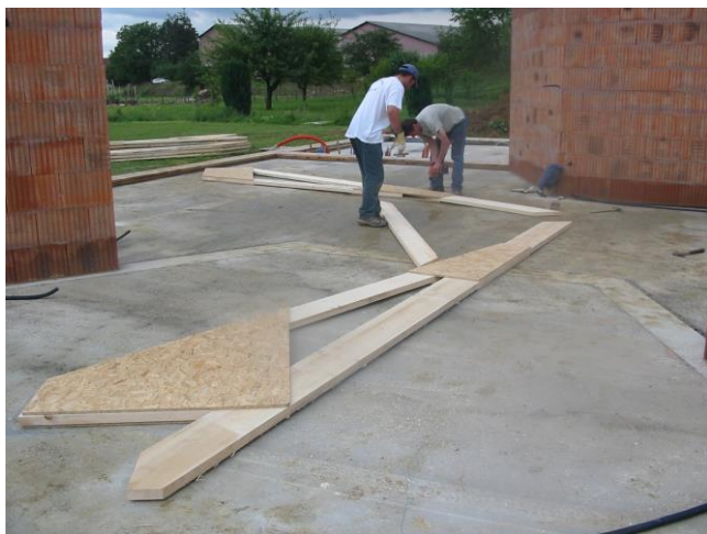
Fabrication des fermettes à l'aide de goussets bois vissés
