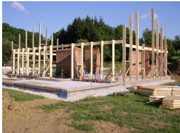
Pose des montants de l'ossature bois et de la poutre filante. Cette dernière sert de lierne (ceinture du bâtiment) et reprendra, à terme, le solivage.
