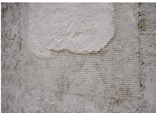
Gros plan sur la trame noyée dans la 2ème couche
