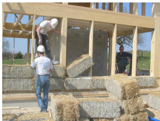
En pose 'fibres horizontales', les ballots peuvent facilement être rentrés 'en force'
