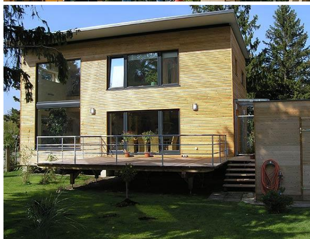
Maison 'très basse énergie' (type passiv-haus) Autriche. Réalisée par assemblage des panneaux fabriqués en atelier, ce type de mise en œuvre représente incontestablement, pour nos pays, l'avenir du matériau 'paille'.
