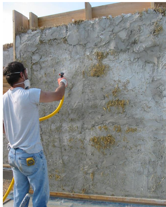
Humidification du support avant application de la deuxième couche (ou corps d'enduit)
