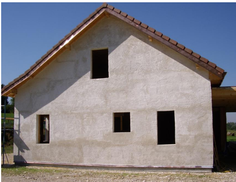
Façade Est : corps d'enduit et toiture terminée
