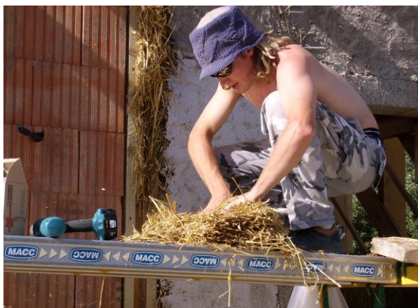
Entre deux séances d'ordinateur, Jeremy Coudel est sur le chantier. Bourrage de paille dans les trous.
