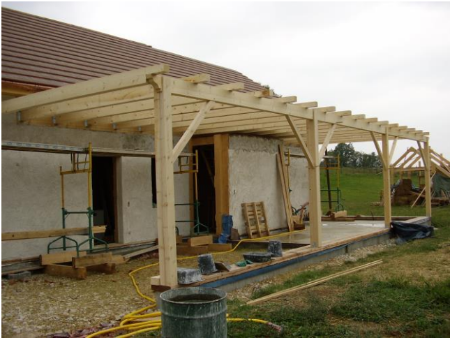
Pose de l'ossature bois du garage-atelier
