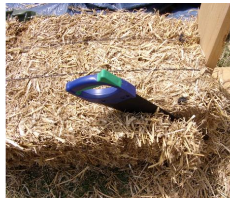
Utilisation d'une aiguille et coupe d'une botte
