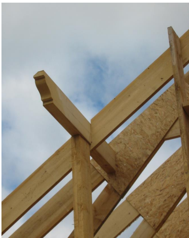
Tête de pignon avec débord de toiture réalisé avec des 'fausses pannes'
