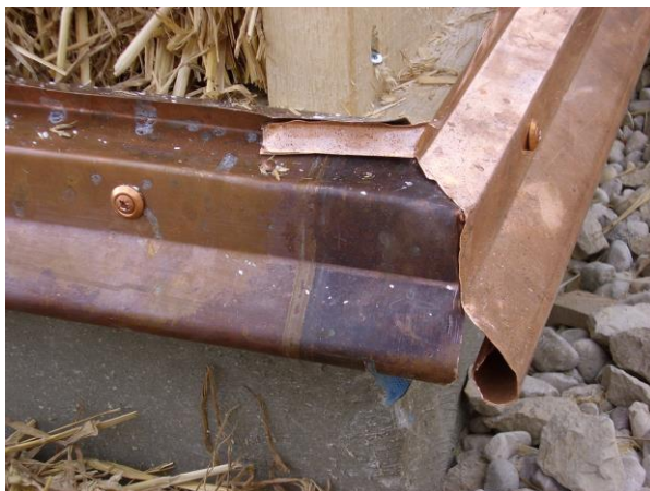
Profil en cuivre, pour la goutte d'eau du pied de mur
