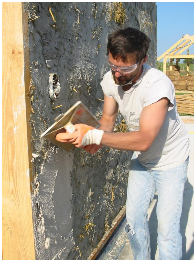
Application du cops d'enduit
