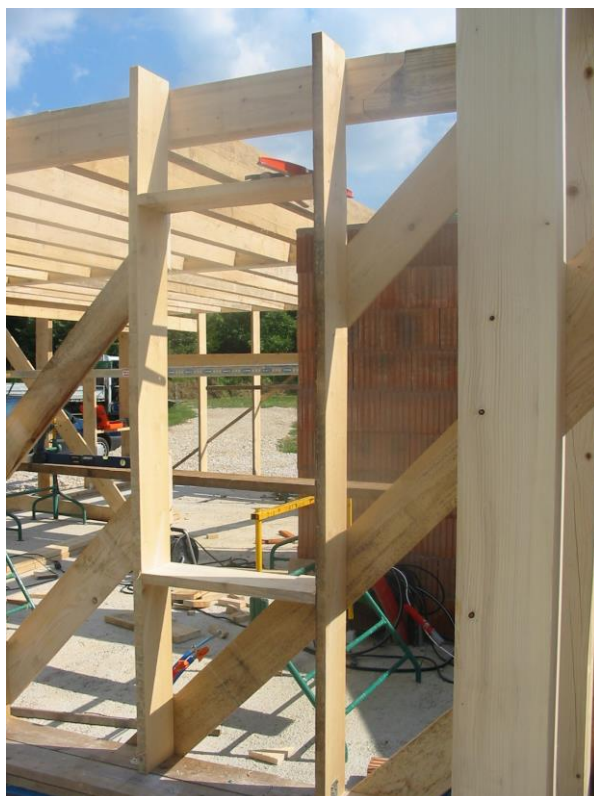
Insertion d'une fenêtre dans le mur
