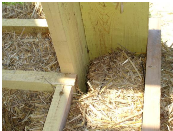
Ballot de paille entaillé dans un angle
