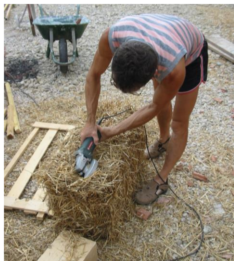
Le propriétaire (Claude Renaudin) pose l'appareil photo pour entailler une botte à la disqueuse
