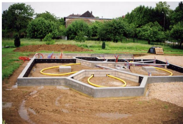
Isolation du mur de soubassement et pose du drain pour ventilation du hérissage
