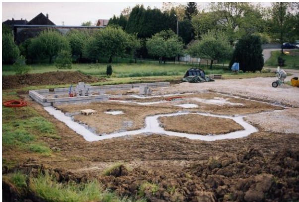
Le terrassement est terminé, les fondations viennent d'être coulées
