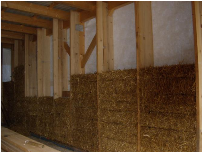
L'espace atelier est également isolé en bottes de paille. Les poteaux sont élargis pour aller de part en part afin de servir de support pour le bardage (extérieur) et les parements intérieurs
