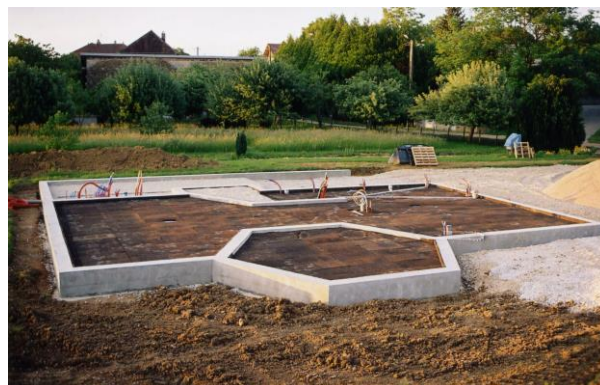
Isolation en panneaux de liège entre hérissage et dalle
