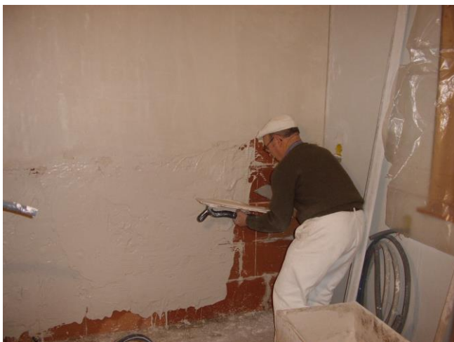
Les cloisons du rez-de-chaussée sont réalisées en brique de terre cuite, puis enduites de plâtre.
