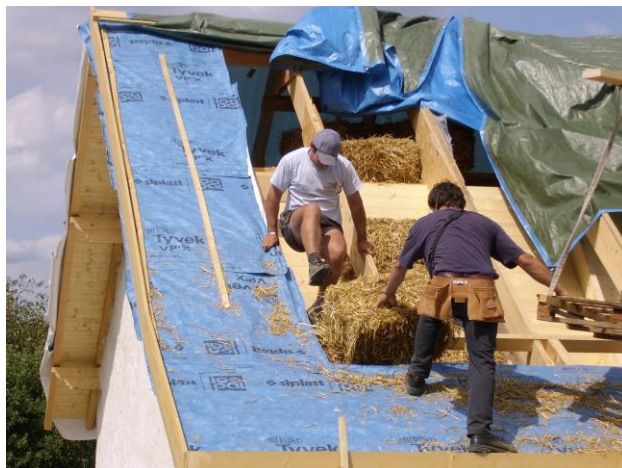
Pose des bottes de paille 'en force' pour l'isolation de toiture
