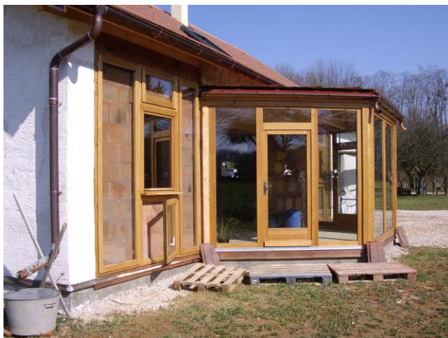
Un coffre rempli de laine de roche permet de réaliser la traversée toiture du conduit de cheminée.
