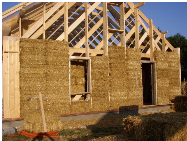
Mur 'bois-paille' en cours de montage
