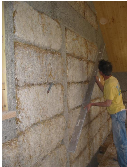
Pose de plaques Fibragglo en interface bois / enduits
