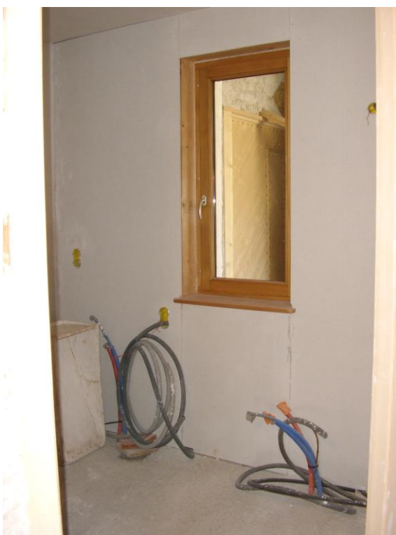
Les cloisons du rez-de-chaussée sont réalisées en brique de terre cuite, puis enduites de plâtre.
