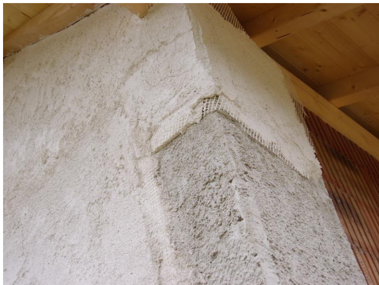
Angle, réalisation du corps d'enduit
