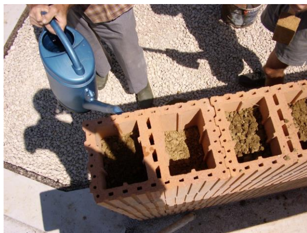
Les murs masse sont remplis de terre pour apporter de l'inertie et aussi, pour les murs capteurs, un déphasage
