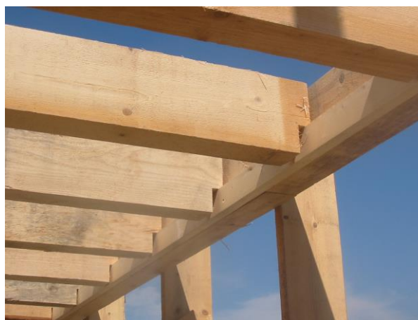
Pose des solives sur poutre filante
