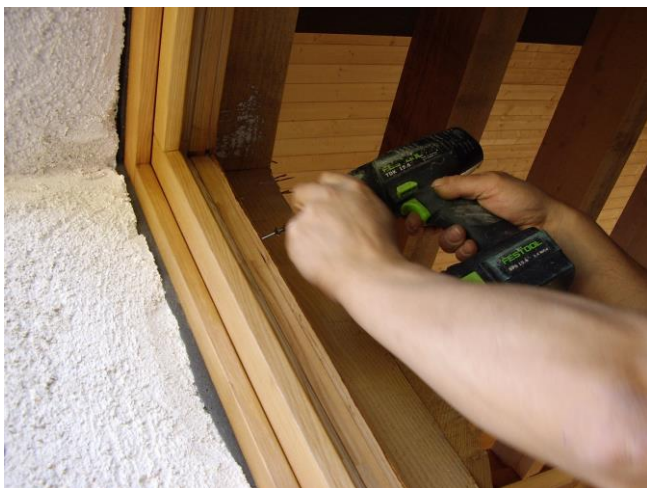
Vue sur le joint compribande pris entre fenêtre et mur. Fixation du dormant d'une fenêtre.
