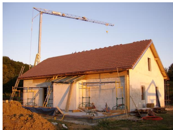
Vue façade nord toiture terminée
