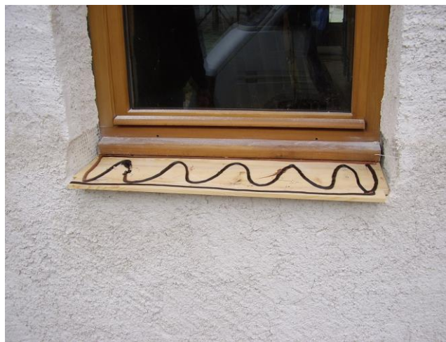
Une tablette bois vient sous les fenêtres. Elle est ensuite encollée pour recevoir l'étanchéité
