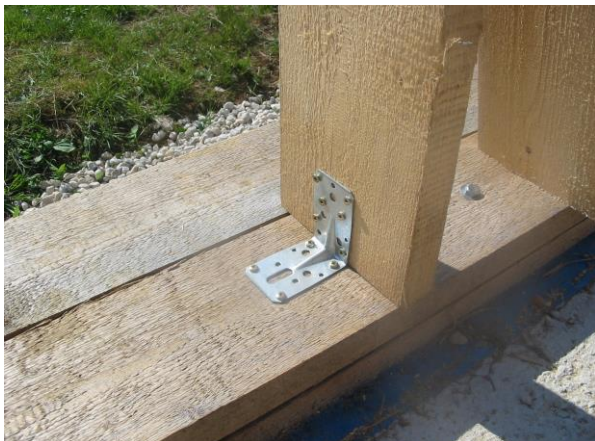
Gros plan sur équerre de fixation
