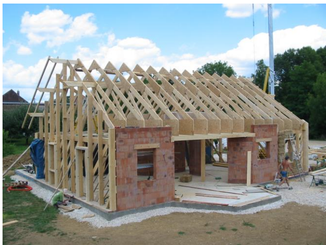
Vue de l'ossature bois du corps d'habitation
