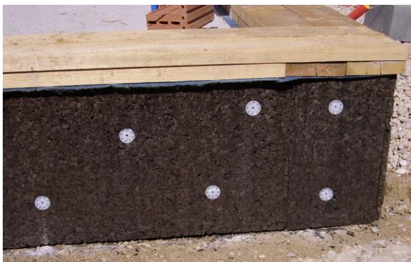
Gros plan sur l'isolation extérieure du mur de soubassement (en panneaux de liège)
