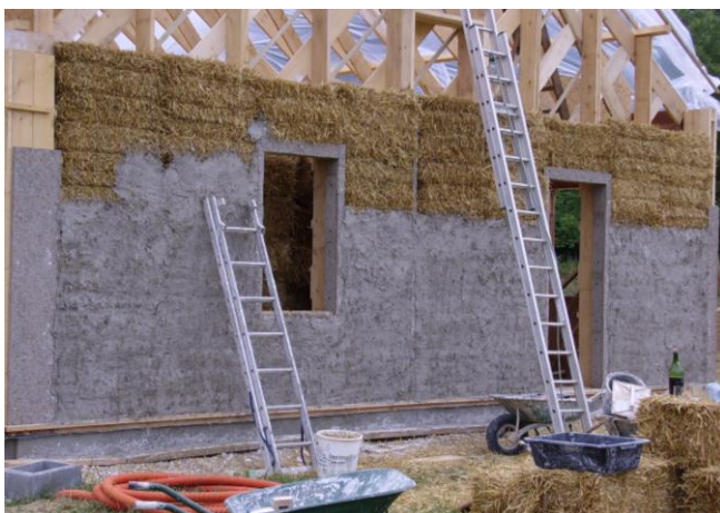
Réalisation de la couche d'accrochage
