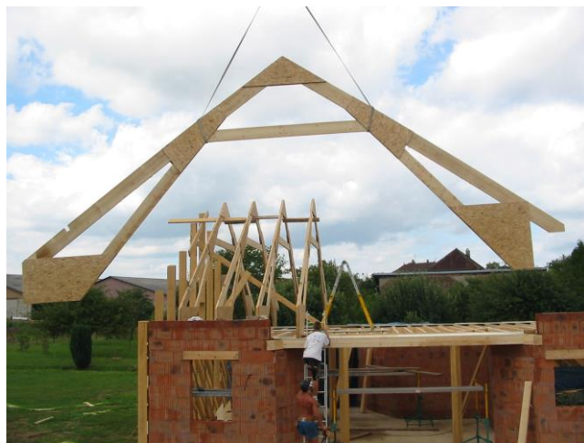
Pose des fermettes en toiture
