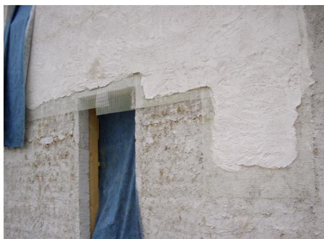
Lors de la progression de la 2ème couche d'enduit, on veille à bien superposer les différents morceaux de trame
