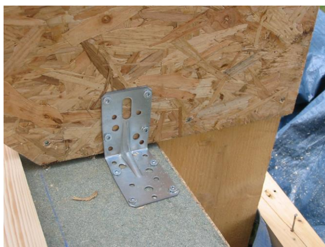
Fixation des fermettes par équerres métalliques
