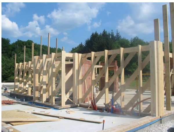
Façade nord : contreventement avec planches obliques clouées sur la face intérieure des poteaux
