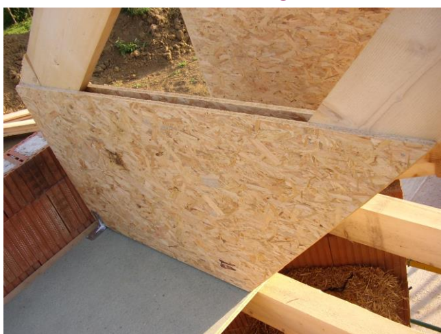
Gousset en OSB en pied de fermette
