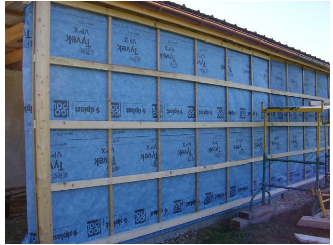
Pose pare pluie, contre lattage et lattage
