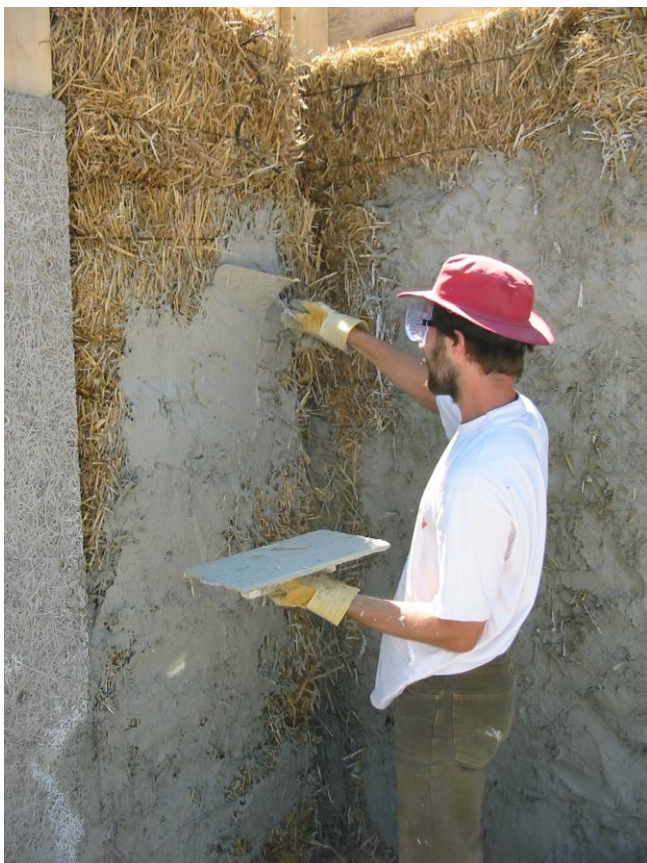
Réalisation de la première couche de l'enduit (appelée également gobetis ou couche d'accrochage)
