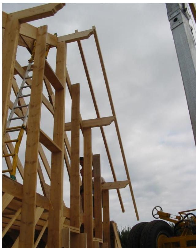
Pose des chevrons sur débord de toiture
