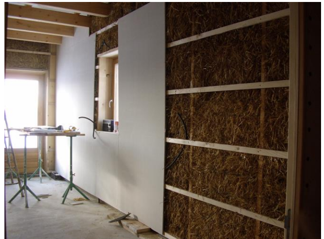
Réalisation des doublages intérieurs en plaques de plâtres de type Fermacell®
