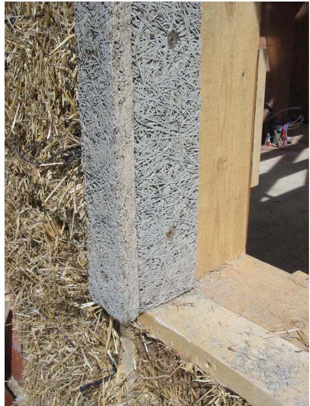
Gestion des entourages de baies en panneaux fibragglo
