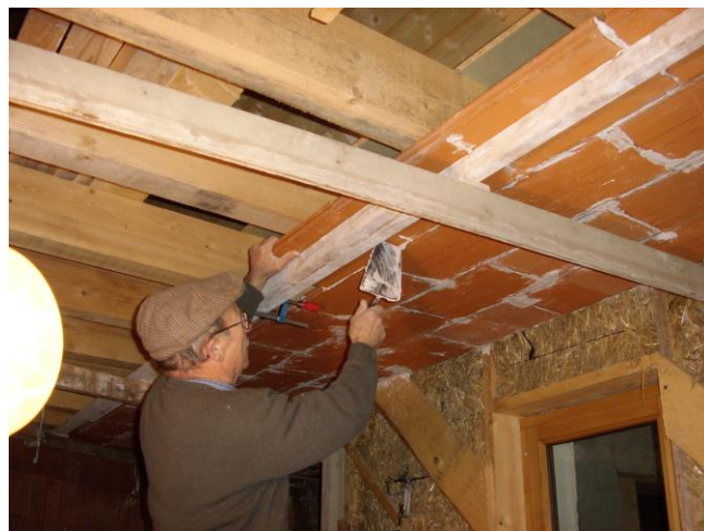
Les cloisons du rez-de-chaussée sont réalisées en brique de terre cuite, puis enduites de plâtre.
