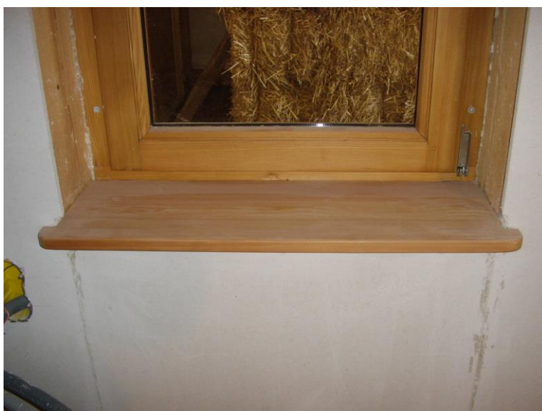
Gros plan sur tablette intérieure et entourage de baie
