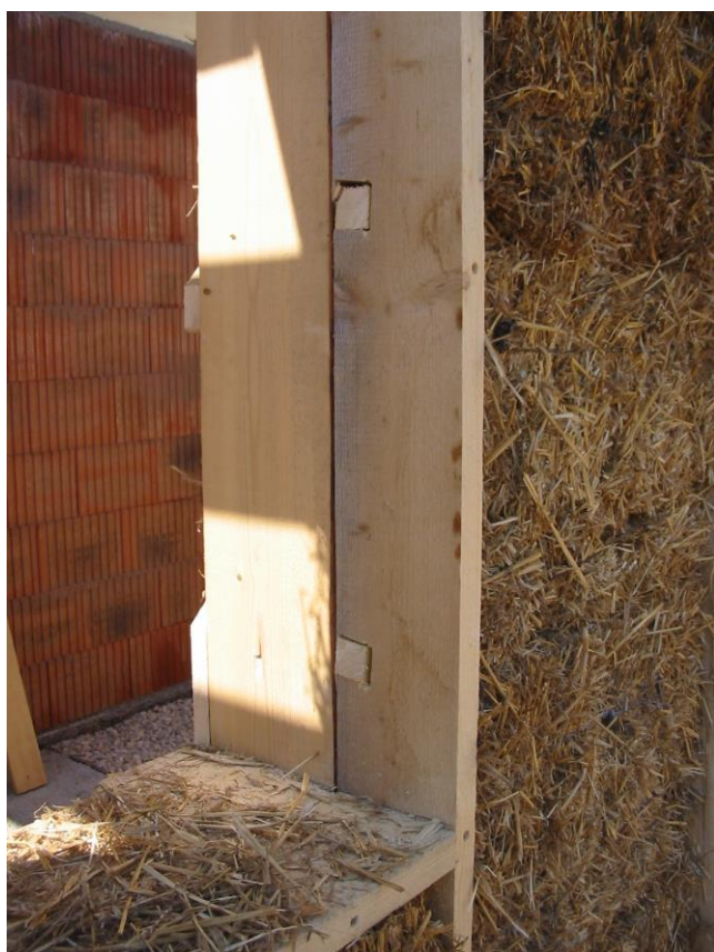
Des entailles sont réalisées dans les pièces support encadrement de fenêtres pour recevoir les liteaux
