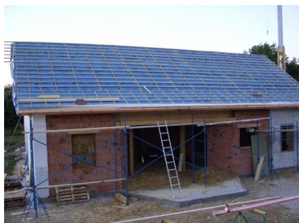
La paille est couverte d'un pare-pluie fixé aux fermettes
