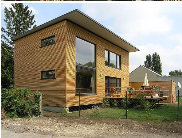
Maison 'très basse énergie' (type passiv-haus) Autriche. Réalisée par assemblage des panneaux fabriqués en atelier, ce type de mise en œuvre représente incontestablement, pour nos pays, l'avenir du matériau 'paille'.
