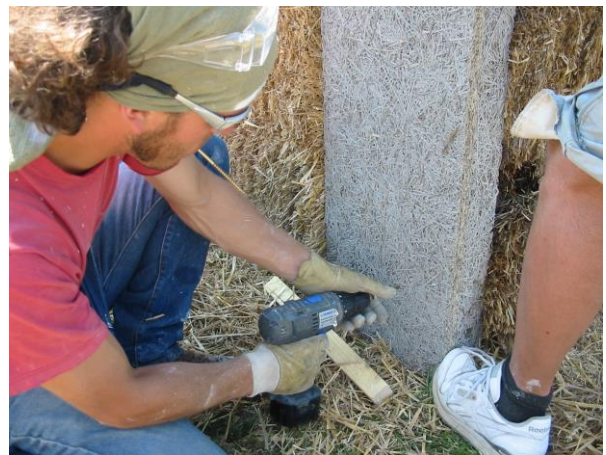
Fixation de panneaux fibragglo en interface bois/enduits
