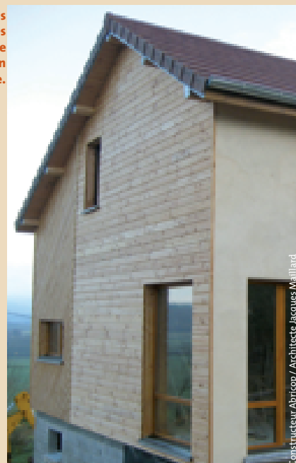
Sur les façades exposées aux pluies battantes, le bardage permet une protection efficace de la paille.
