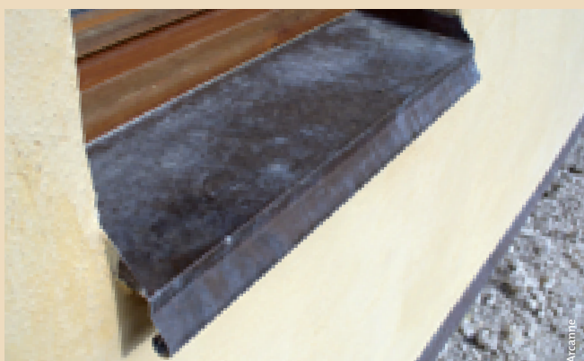
Dans les murs enduits sur paille, les boîtiers électriques sont vissés sur l'ossature ou sur des taquets en bois. Au final l'enduit doit couvrir derrière ces boîtiers. Important, les profils « goutte d'eau » pour les appuis de fenêtre.
