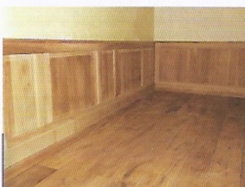
Boiserie à l'ancienne - Les lambris bois sont une solution très ancienne pour réduire les pertes thermiques de nos corps par rayonnement vers les parois. Du point de vue thermique, l'effet maximum est obtenu en faisant monter ce parement intérieur jusqu'à hauteur d'épaule, le torse étant la partie la plus sensible aux déperditions. Les bois de pays à faible densité (épicéa, pin sylvestre, peuplier...) sont préférables du point de vue thermique aux bois lourds comme le chêne. Photo P.-Y. Lancelot
