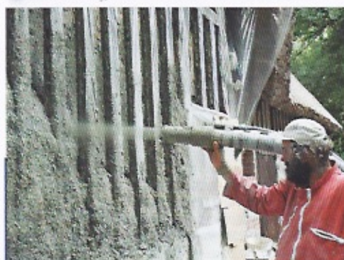
Réfection d'un mur à colombages en Normandie. Les vieux murs à pans de bois sont dans tous les cas insuffisamment isolants. Si le hourdage extérieur entre colombages n'est pas décoratif (briques, ...) le mieux est de le remplacer par un conglomérat composé d'un liant (chaux ou argile) et d'un granulat végétal (ici chenevotte de chanvre) entre les colombages. En arrière des colombages, ce remplissage déborde de 15 cm environ et constitue une paroi monolithique. L'opération peut s'effectuer par l'extérieur ou par l'intérieur. Source : Bitlithic, Photo B. Leroux
