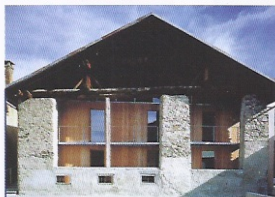
Reaffectation d'une annexe agricole - Ce geste architectural fort permet de conserver l'intégralité de l'existant en glissant à l'intérieur une peau habitable de très haute qualité thermique (ici de niveau passif). Pas toujours réalisable évidemment, mais dans le cas présent, cela a permis de sauver cette « pauvre » grange dans un milieu villageois. N'oublions jamais que la performance thermique c'est d'abord de l'architecture. Source : Minergie, architectes D. Marques & B. Burkichen
