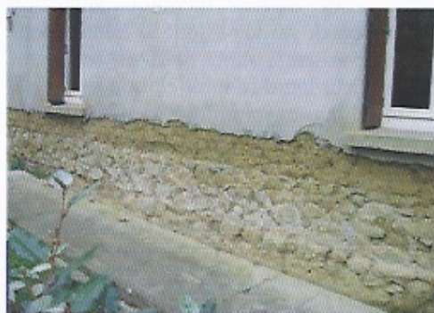
Saignée de sauvetage sur un mur en adobes dans le Gers - Prisonniers de leur enduit ciment, isolant avec pare-vapeur, trottoir ciment, les murs de cette maison du XIX e siècle étaient en train de se « liquéfier ». Deux ans après l'intervention de l'urgentiste (Gérard Vivès), la fissure que l'on voit au centre s'était fortement réduite. Temps pour déconstruire tranquillement les erreurs réalisées et refaire au bâti une peau digne de lui. Photo J.-P. Olliva
