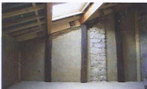
Enduit correcteur thermique à base de fibre végétale (ici lavande et chaux) - La chènevotte, les anas de lin, la paille de lavande... sur 2 à 3 cm d'épaisseur constituent des revêtements à faible émissivité qui suppriment la sensation de paroi froide, et permettent de réduire de plusieurs degrés la température de l'air intérieur, et donc les déperditions. La tête de mur en calcaire dur, de belle facture, a été conservée visible et reste un point froid, mais elle impacte peu le confort d'ensemble de la pièce. Si on doit se trouver le dos à elle, rien n'empêche de s'asseoir dans un fauteuil Voltaire ! Photo J.-P. Oliva
