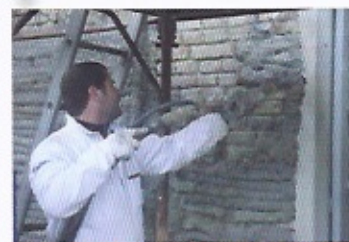
Pose d'un enduit isolant de façade directement sur briques pleines. Seul le corps d'enduit est isolant ( \lambda 0,045 à 0,08). L'éventuel gobetis d'accrochage et la couche de finition sont classiques. La perspiration et la capillarité sont excellentes pour la plupart des produits. Le surcoût est de l'ordre de 5 à 8 % par rapport à un chantier de ravalement de façade classique. Le traitement convient aussi au parement intérieur. Photo Dissen.
