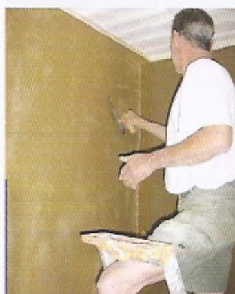
Pose d'un enduit terre - Le plâtre et l'argile sont aussi d'excellents liants pour les fibres végétales, et leur bilan environnemental est bien meilleur que celui de la chaux. Les couleurs et textures possibles laissent d'innombrables variations aux décorateurs. Photo Scop Abricop
