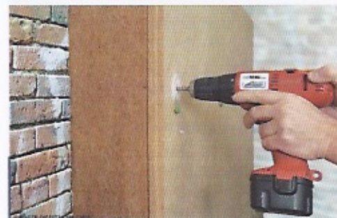
Pose de panneaux de fibres de bois à contreparements compressibles. Sur des parois relativement irrégulières, l'écrasement des fibres jusqu'au fond des anfractuosités assure l'effet de mèche indispensable pour extraire par capillarité l'humidité éventuelle du mur. Les stries coté rigide du complexe isolant facilitent l'accroche de l'enduit de finition (plâtre ou terre). Source : Unger-Diffutherm
