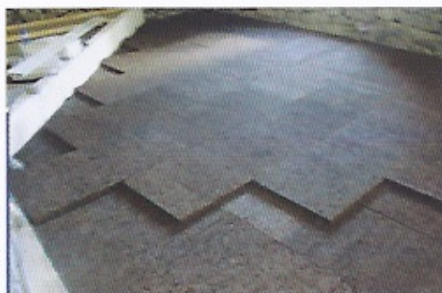
Panneaux de liège expansé en isolation de sol sur terre-plein. Pour tout matériau en contact avec le sol il est d'une importance primordiale qu'il soit imputrescible et non capillaire. Source : blog « pieducole »
