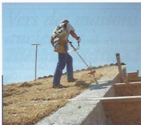
Isolation sur rampants en bottes de paille.
