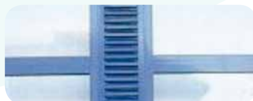
Figure 18 : Grille verticale intégrée dans la menuiserie. Source : energieplus-lesite.be
