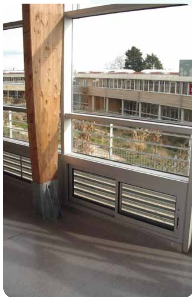
Grilles de ventilation en partie basse des circulations – Lycée Maryse Bastié - Maître d'ouvrage : Conseil régional du Limousin - Maître d'œuvre : ATELIER 4 - BE HQE : TERAQ.
