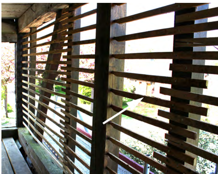
Illustration 16: Lattage formant lattis par endroit (Yan Minne)
