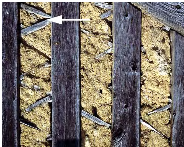
Illustration 10: des éclisses posées en zig-zag (© Région Centre-Val de Loire, Inventaire général, Robert Malnoury)
