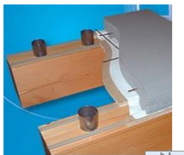
Plancher collaborant bois/béton
