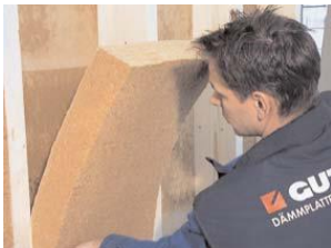
Panneaux entre ossature
