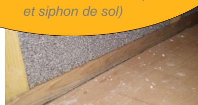
Béton isolant chaux/billes de liège expansé. (Photo M Gajic)
