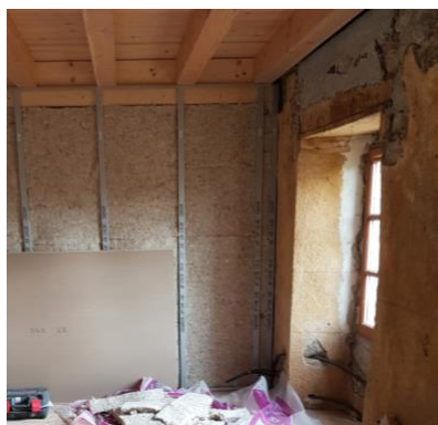
Isolation intérieure (photo Biofib)
