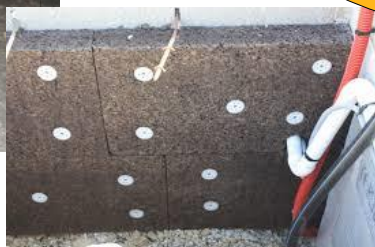
Panneaux de liège expansé en sol
