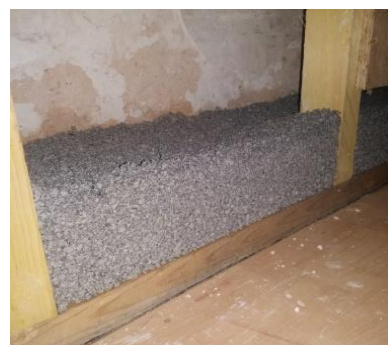
Béton isolant chaux/billes de liège expansé. (Photo M Gajic)
