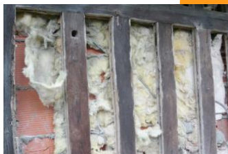
Mauvais vieillissement d'isolant
