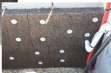
Panneaux de liège expansé en sol
