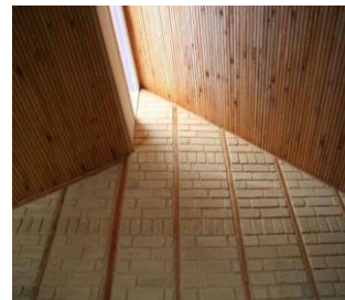
Briques de terre comprimée (BTC)
