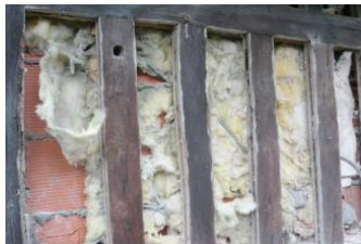
Mauvais vieillissement d'isolant
