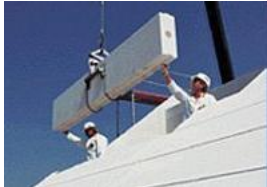
Panneaux en maçonnerie légère
