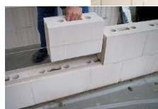
Briques silico-calcaire
