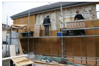
Panneaux entre ossature
