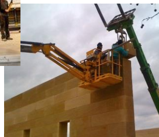
Blocs de pierre sciés, pisé préfabriqué...
