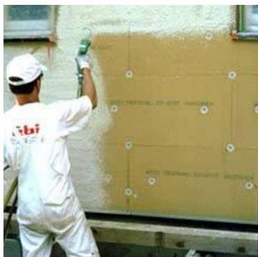
Panneaux de fibres de bois denses en ITE
