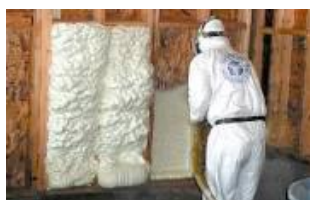
Mousse à projeter à base d'isocyanates. Famille des PUR
