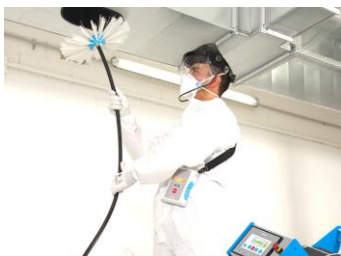
Nettoyage des conduits VMC
