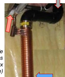
Système de récupération des calories sur eaux grises (power pipe)
