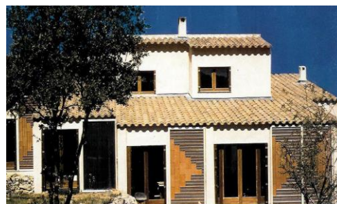
Mur capteur avec la "brique solaire" (Brique Moya®)
