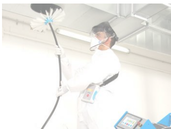
Nettoyage des conduits VMC
