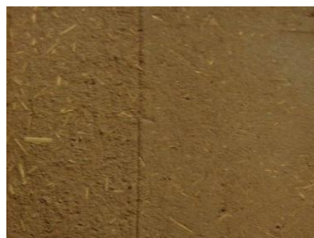
Intégration de végétaux dans des enduits terre, chaux
