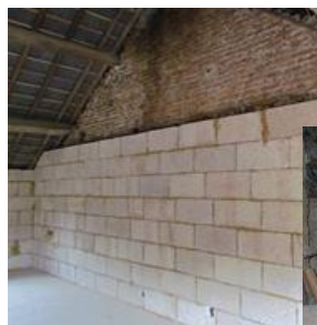
Cloison de doublage (photo ISOHEMP)
