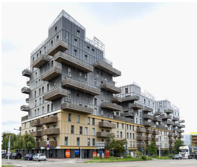
Résidentiel Strasbourg, 2018 - 11 étages, 142 logements ASP Architecture + KOZ Architecte Ossature CLT, isolation extérieure en paille
