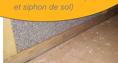
Béton isolant chaux/billes de liège expansé. (Photo M Gajic)
