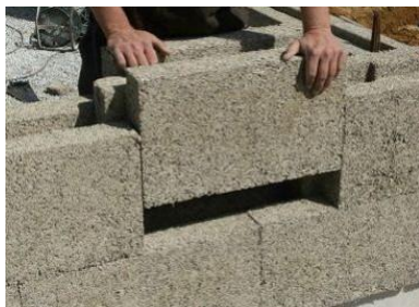
Briques de chanvre (BIOSYS®, avec ossature BA)
