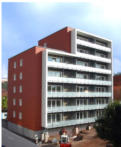
Logement social à St Dié (88), 2014 - 8 étages ASP Architecture + KOZ Architecte Ossature CLT et ITE paille : bilan carbone positif de 1100 tonnes de CO 2 , contre un bilan négatif de 600 tonnes pour une solution classique béton-polystyrène
