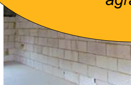
Cloison de doublage (photo ISOHEMP)
