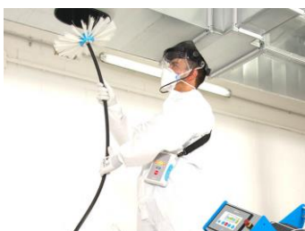
Nettoyage des conduits VMC
