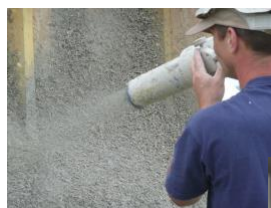
Projection de chanvre-chaux, ou mieux, de chanvre-terre
