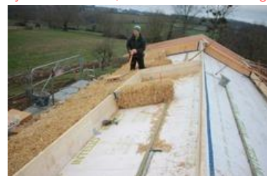
Bottes de paille (ajustement via un système médian, entre coffre et sarking)
