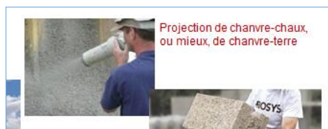
Projection de chanvre-chaux, ou mieux, de chanvre-terre
