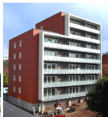
ITE : coffres bois/paille fixés sur ossature CLT Le toit vosgien (88), 2014
