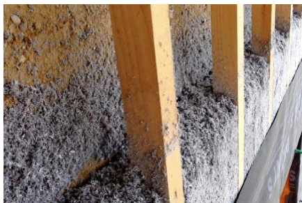
Ouate de cellulose projetée humide
