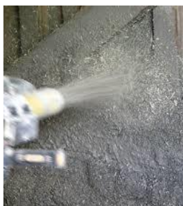
Projection de chanvre-chaux, ou mieux, de chanvre-terre
