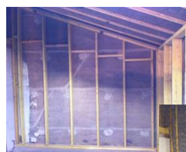
Ouate de cellulose projetée sur mur pisé
