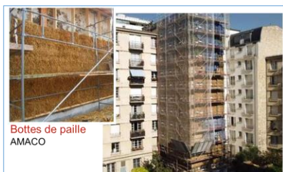
Bottes fixées par sangles sur mur maçonné. ParisHabitat, 2021
