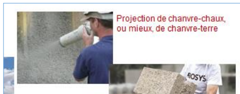
Projection de chanvre-chaux, ou mieux, de chanvre-terre
