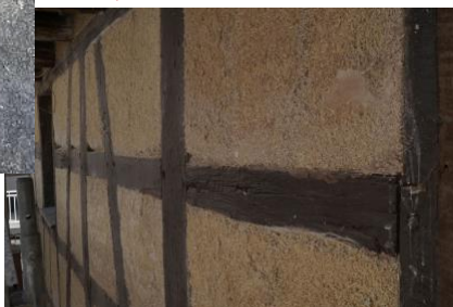
Projection de chanvre-chaux, ou mieux, de chanvre-terre
