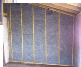
Ouate de cellulose projetée sur mur pisé
