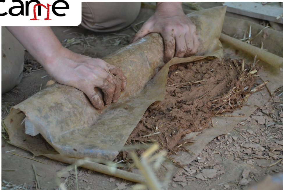
Fabrication d'une quenouille. Chantier Bois-Terre-Paille. Crouzet-Migette 2025
